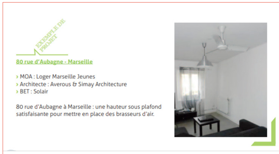
Exemple de ventilateur brasseur d'air dans le cadre d'une rénovation initiée par Loger Marseille Jeune
